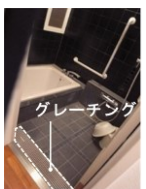
グレーチングを設けることでフラットな設計とした浴室出入口
