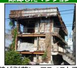
・外壁が剥落し、アスベスト飛散の おそれ。
